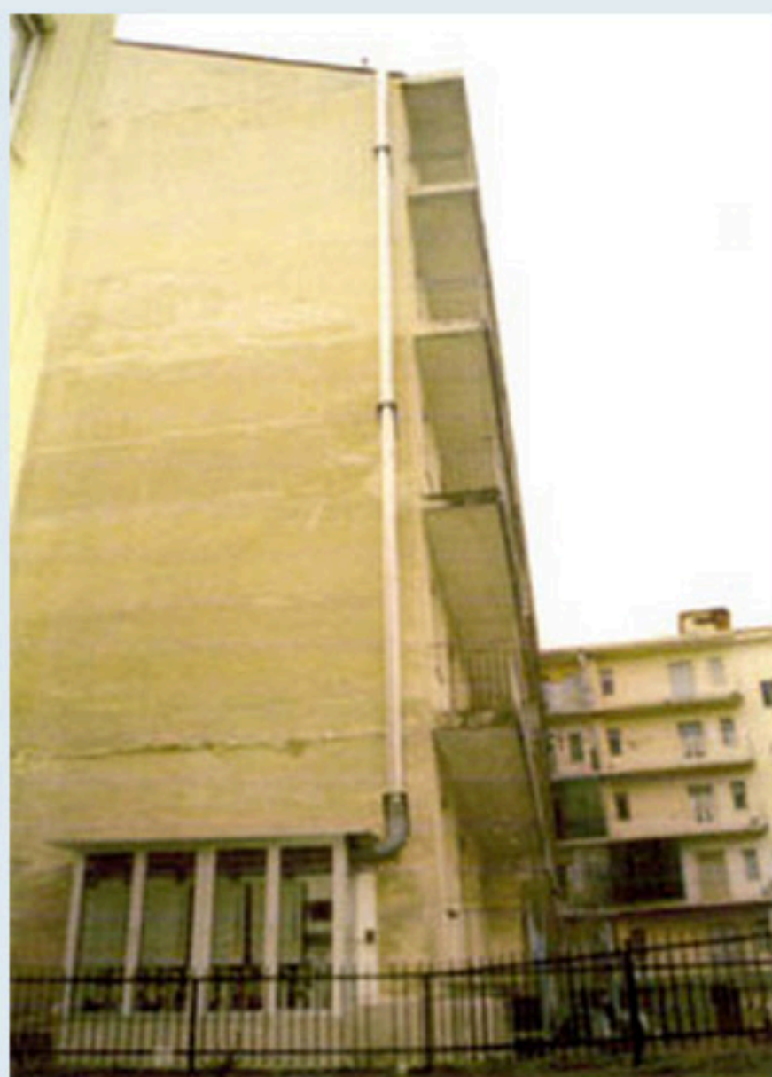
Vista complessiva intervento, con camino
