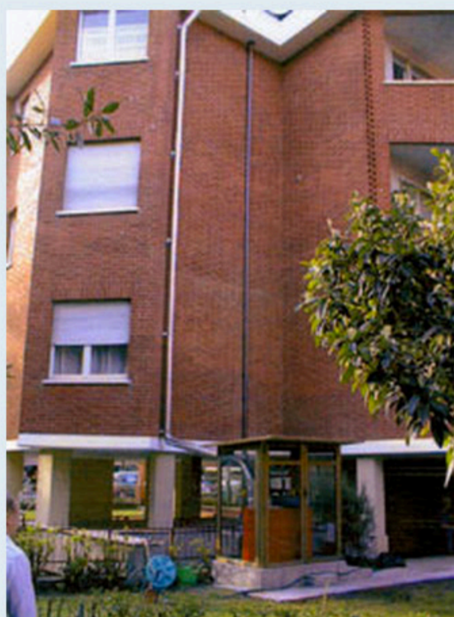
Vista generale con camino esterno
